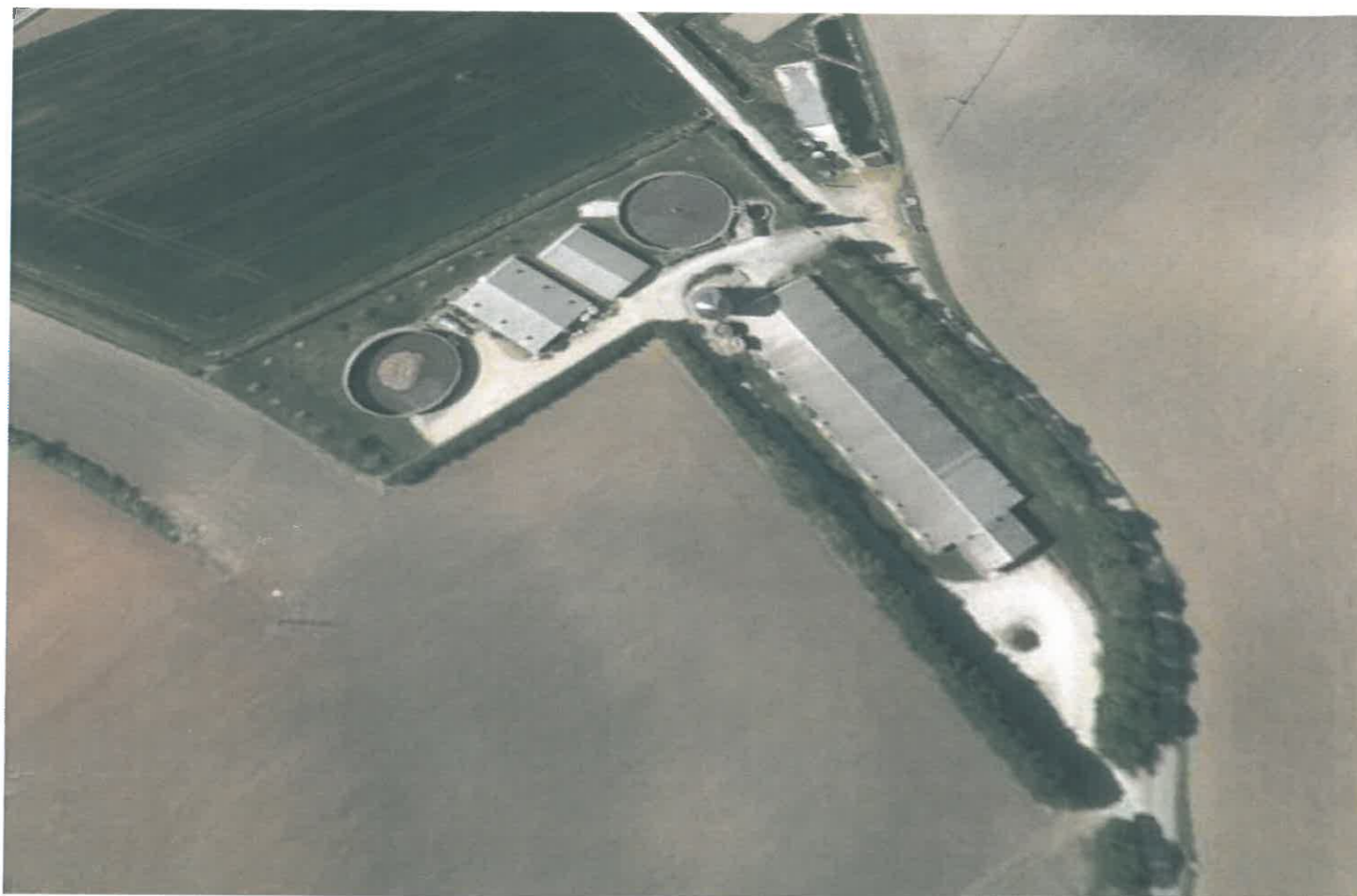
VUE AÉRIENNE (source géoportail)
